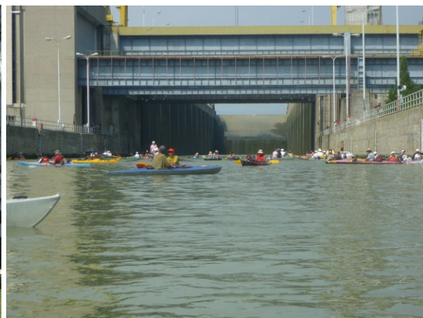
Doppelschleuse 30 m Höhenunterschied
