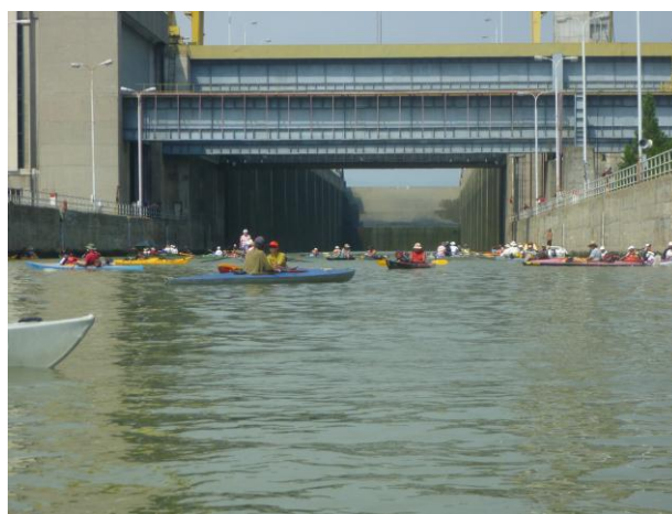
Doppelschleuse 30 m Höhenunterschied
